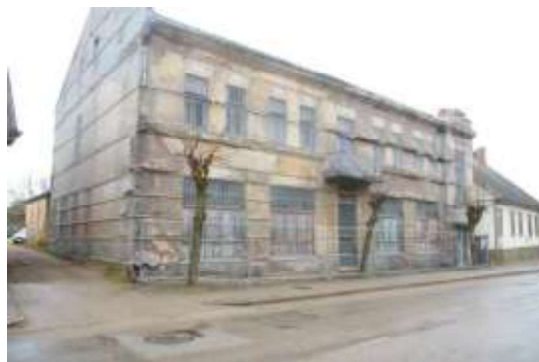
Kopskats uz vērtējamo Objektu no Atmodas ielas puses
